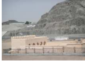
Cemerât Köprüsünün yakınlarındaki "Biat / Akabe Camisi"
